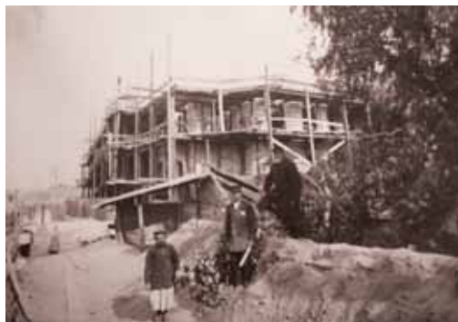
Строительство дома А. Наумова
